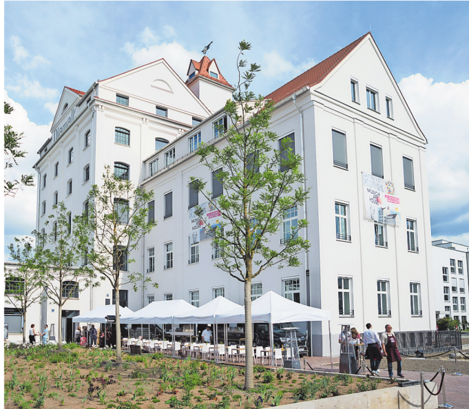
DIE ALTE SUPPENWÜRZE IM DIAMALT-GELÄNDE WURDE REVITALISIERT. FOTOS: 1000 SATELLITES GMBH
